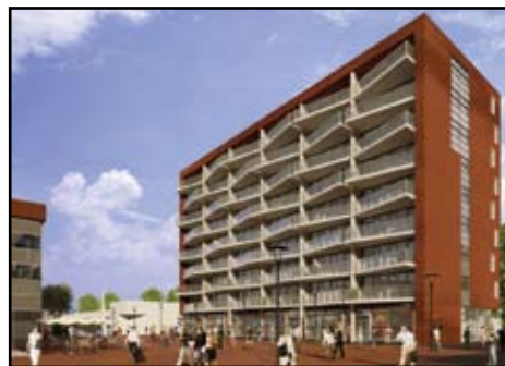
De garage is half verdiept aangelegd en de gevels van de garage zijn opgenomen in het gevelbeeld van de gebouwen.
