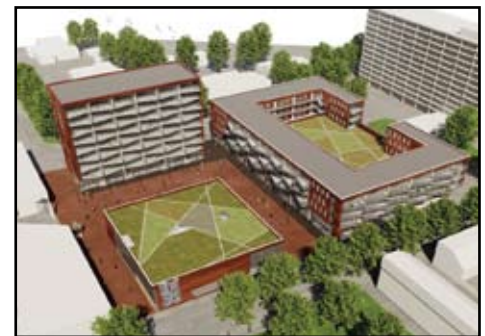
Onder de rechthoek van de drie gebouwen bevindt zich de parkeergarage Rotterdam Hoogvliet.
