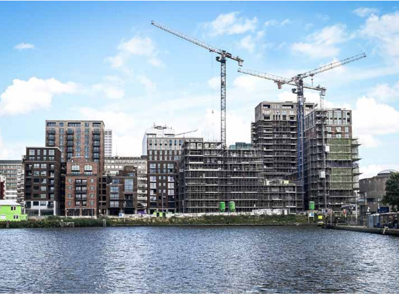
Op de kop van de Coolhaven in Rotterdam, tussen het Erasmus MC en de Hogeschool Rotterdam wordt druk gebouwd aan Little C.
