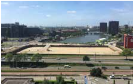
VMV Projecten B.V. heeft een schone, nieuwe en draagkrachtige ondergrond aangebracht.
