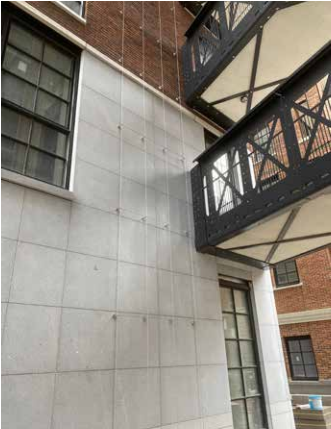
RVS 316 kabels en kabel gaasnetwerken langs en tussen de gevels laten diverse klimplanten tientallen meters omhoog groeien.
